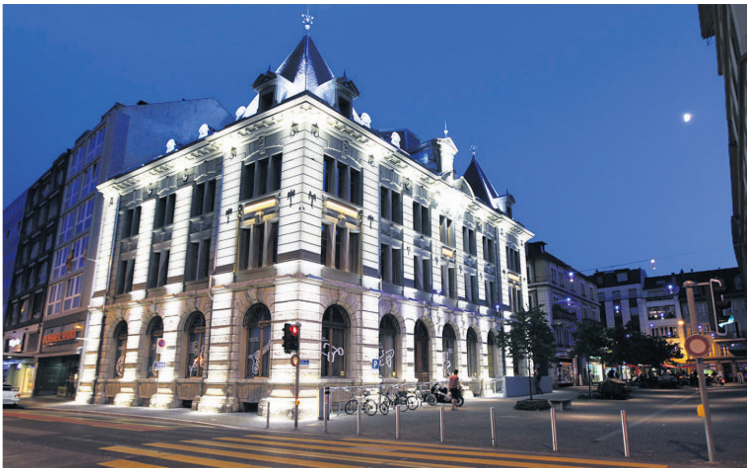
Des luminaires LED fraîchement installés sur le bâtiment éclairent désormais le bâtiment et la place de l'Ancienne-Poste.
